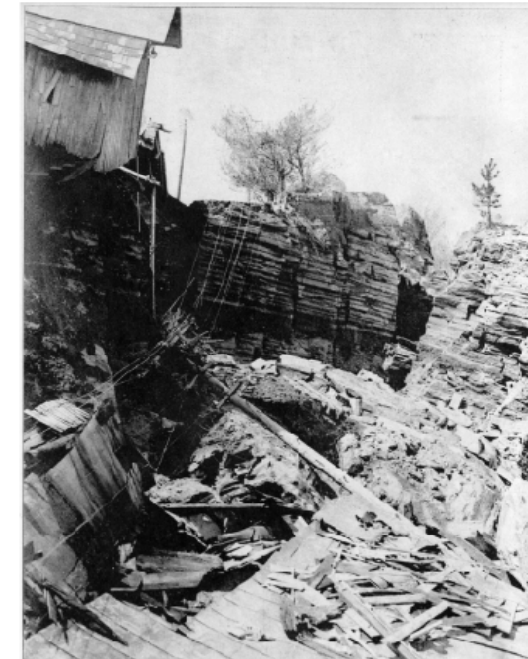
細互層の発達した地すべり移動 土塊の状況。(齊藤一郎氏所蔵写真) 11)
