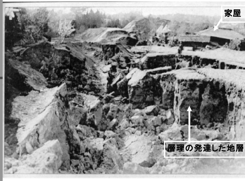
写真-2 北浦漁港周辺に発生した岩盤すべりの状況 (齊藤一郎氏所蔵写真) 11)
